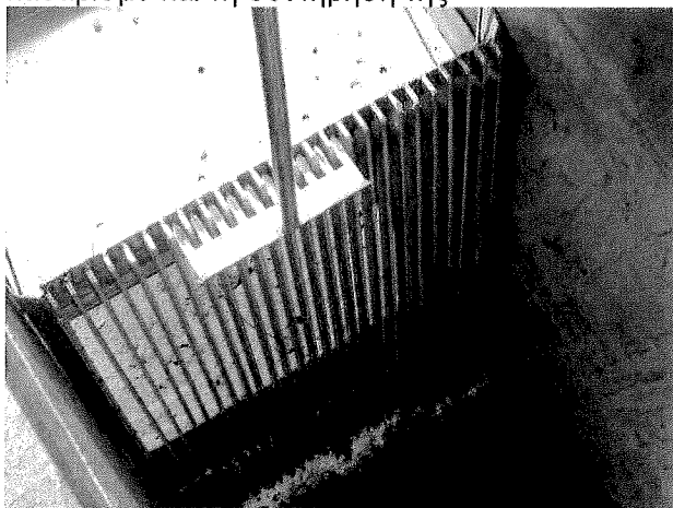
Εικόνα 2 Χειρωνακτικά καθαριζόμενη σχάρα
